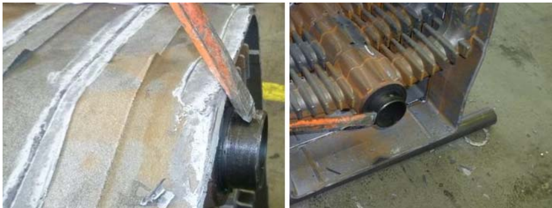
Demontáž původních kuželových vložek
