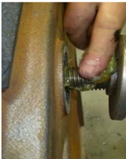
Aplikace vazeliny na závity stahovacího přípravku
