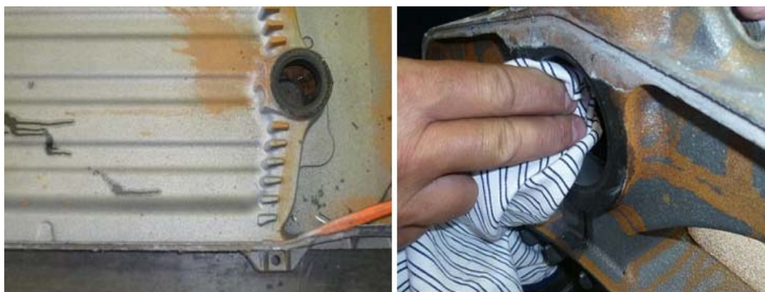
Čištění dosedacích ploch mezi články
